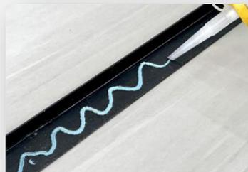
3. Asegurar el perfil a la grada con cinta adhesiva hasta que el adhesivo de fijación haya completado su endurecimiento según las indicaciones del fabricante.
