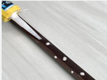
3. Asegurar el perfil a la grada con cinta adhesiva hasta que el adhesivo de fijación haya completado su endurecimiento según las indicaciones del fabricante.
